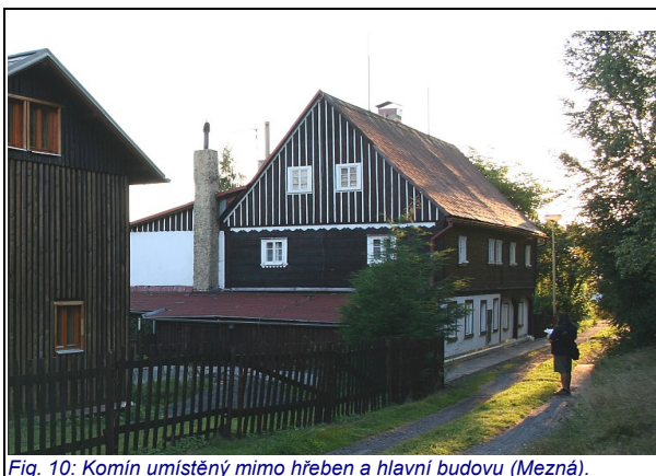
Fig. 10: Komín umístěný mimo hřeben a hlavní budovu (Mezná).
