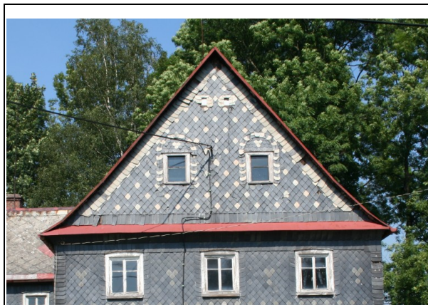
Fig. 5: Námětky doplňují tvar střechy a jsou typickým konstrukčním prvkem staveb lidového stavitelství.
