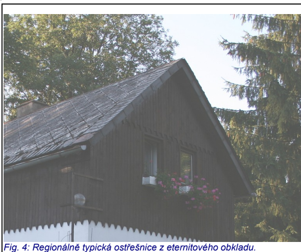
Fig. 4: Regionálně typická ostřešnice z eternitového obkladu.
