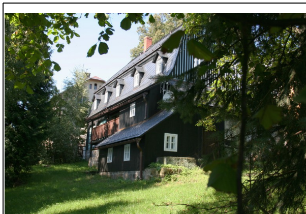
Fig. 7: Vikýře v mansardové střeše u památkově chráněného objektu.
