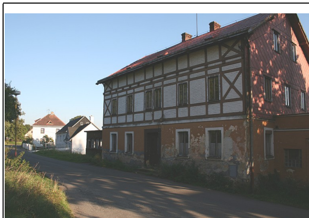
Fig. 22: Hrázděná konstrukce s režným zdivem z pálených cihel (Mezná).
