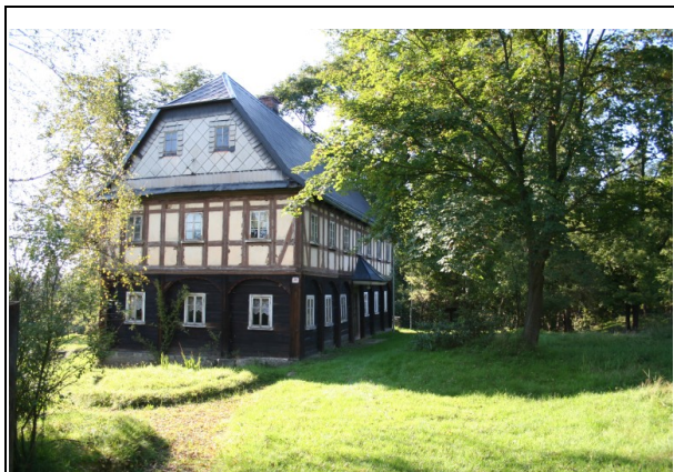
Fig. 21: Roubená stavba s hrázděným patrem a hliněnou výplní (Mezná).
