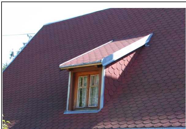
Fig. 6: Vikýř s pultovou střechou.
