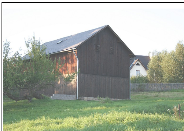
Fig. 24: Příklad rámové konstrukce u stojícího hospodářského objektu - stodola (Mezná).
