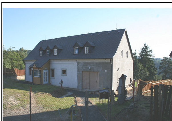
Fig. 8: Vikýře se sedlovou střechou - velké množství na malé ploše (Mezná).
