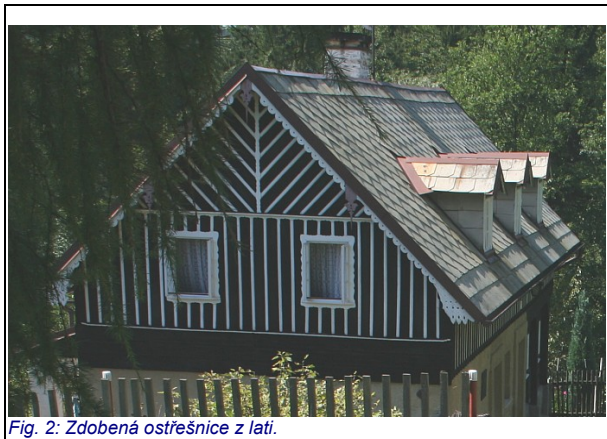
Fig. 2: Zdobená ostřešnice z laťi.
