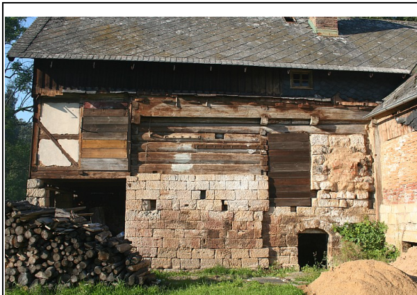
Fig. 14: Ukázka různých zdících technologií a úprav povrchů na jednom objektu.
