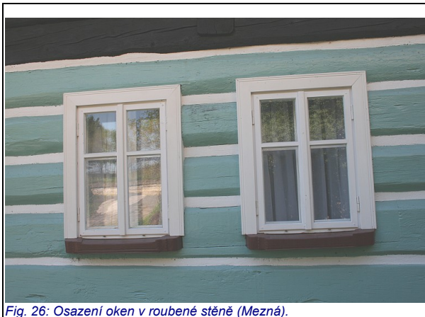
Fig. 26: Osazení oken v roubené stěně (Mezná).
